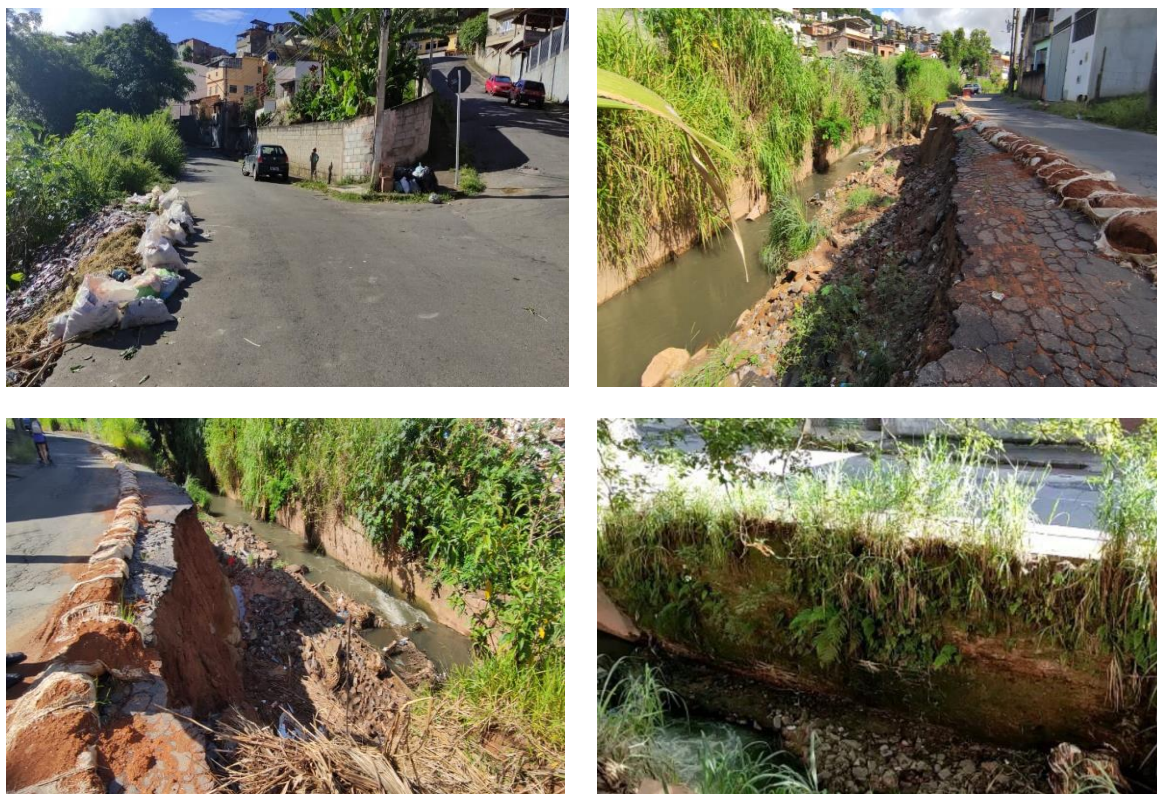
Figura 7: Talude e via a serem reconstruídos e remoção de rip-rap dentro do canal (objeto de uma outra Licitação).
