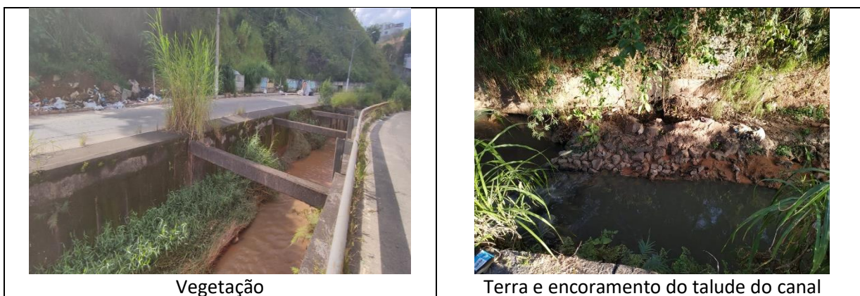
Figura 14: Obstruções existentes demonstrando a falta de manutenção regular.
